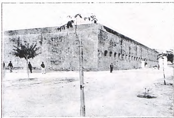
Ἐξωτερικὴ ἀποψὶς τῶν Φυλακῶν Κεφαλληνίας
